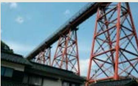
■写真2—民家の間からそそり立つ橋脚 撮影：筆者
