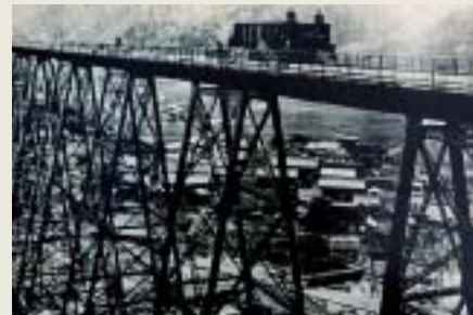
■写真3—組み上げられた餘部鉄橋 写真提供：藤原月代(美方郡香美町)
