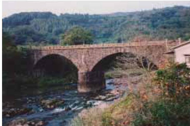
■写真6—赤松橋 明治30年架設 日出町 橋長47.0m 橋幅 5.9m 2連アーチ
