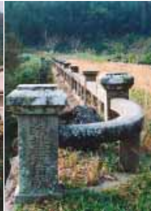
■写真7—袖高欄と親柱
