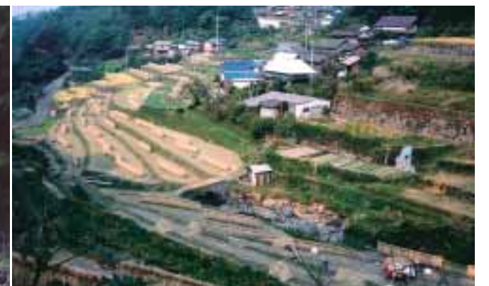
■写真13—棚田の中の両合川橋 宇佐市院内町 国登録有形文化財 大正14年架設
