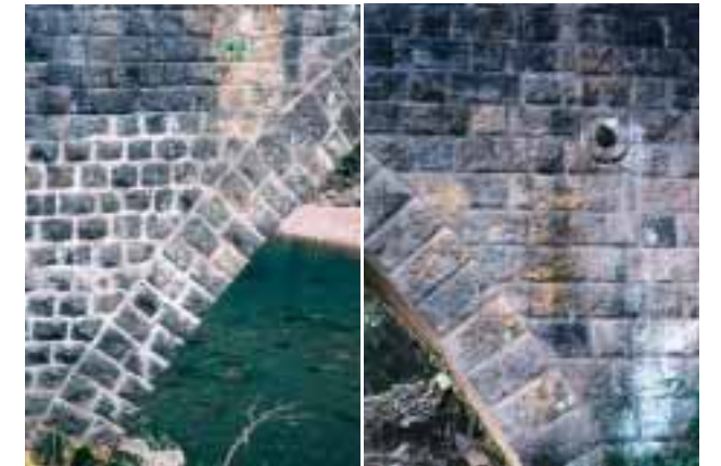
■写真5—布積みの壁面 出会橋（左）阿南橋（右）
