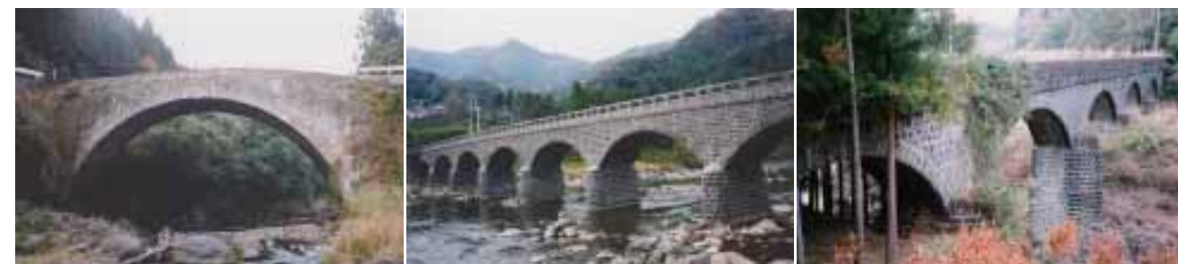
■写真1—虹澗橋（こうかんきょう） 文政7年（1824）架設 豊後大野市・白杵市 野津町 大野川支流三重川 国指定重要文化財（平成11・12・1） 橋長31.0m 橋幅6.5m 単一アーチ
