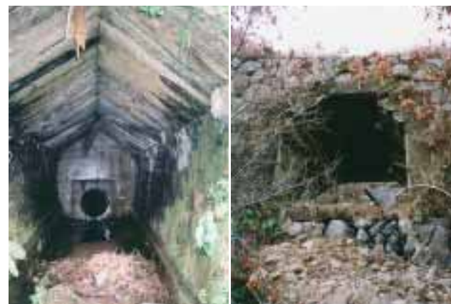
■写真8—アーチ以外の石橋 合掌型の草深野石橋(左) せり持式の松株橋(右)
