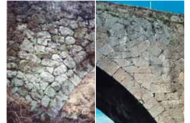
■写真4—乱積みの壁面 岩戸橋（左）虹澗橋（右）
