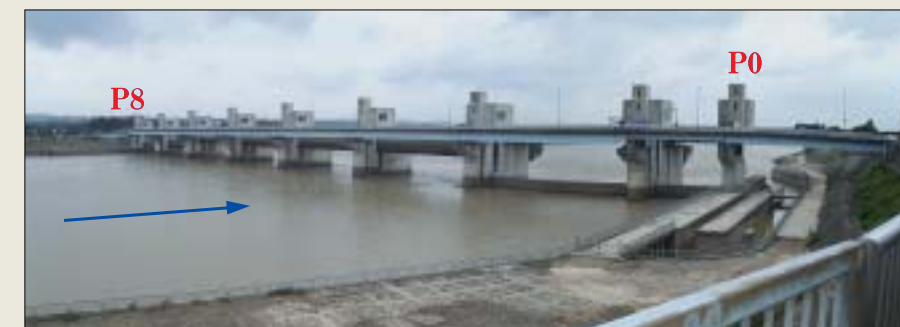
■写真1—妙見堰の全景（上流側より）
