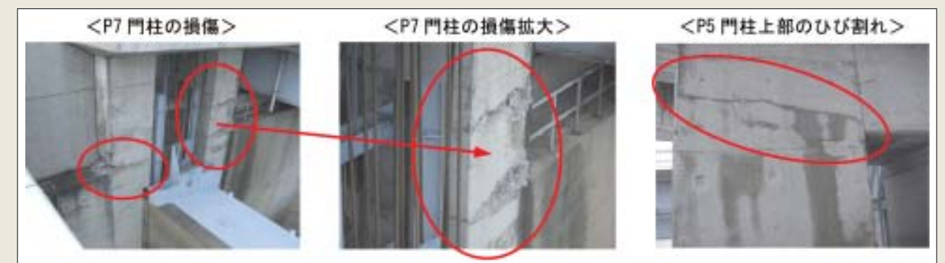
■写真2—妙見堰の損傷状況
