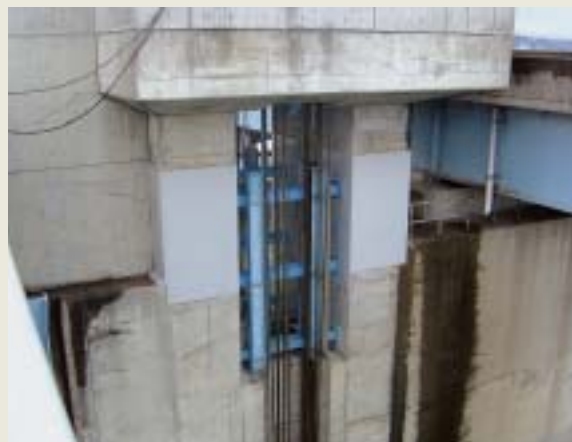
■写真3(1)—P7堰柱の補強状況(全景)
