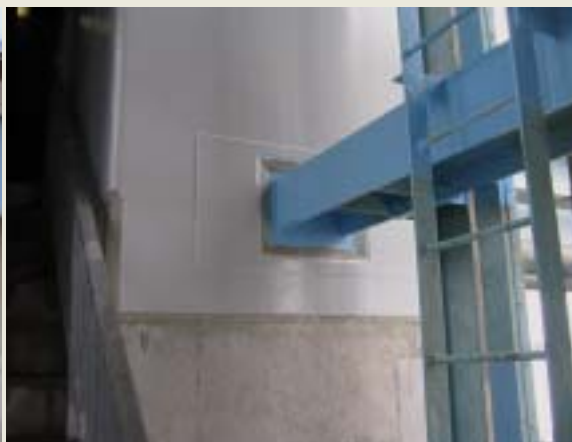
■写真3(2)—P7堰柱の補強状況(拡大)
