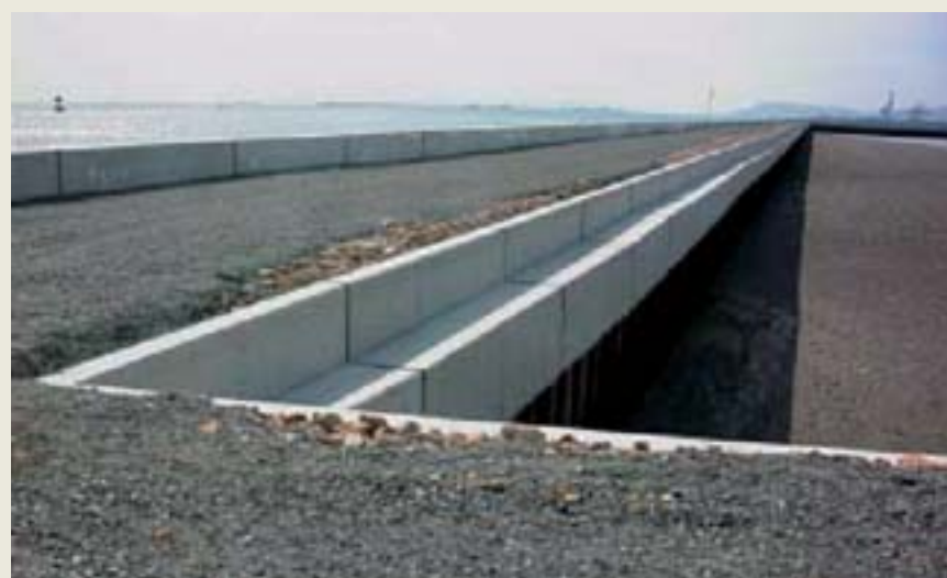
■写真1—神戸沖処分場遮水工
