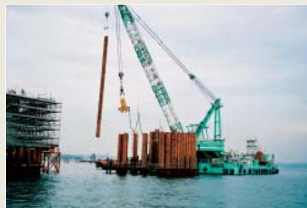
■写真1—鋼管矢板井筒の施工
