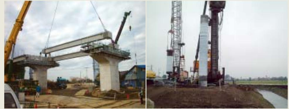
■写真2—PCU桁架設
