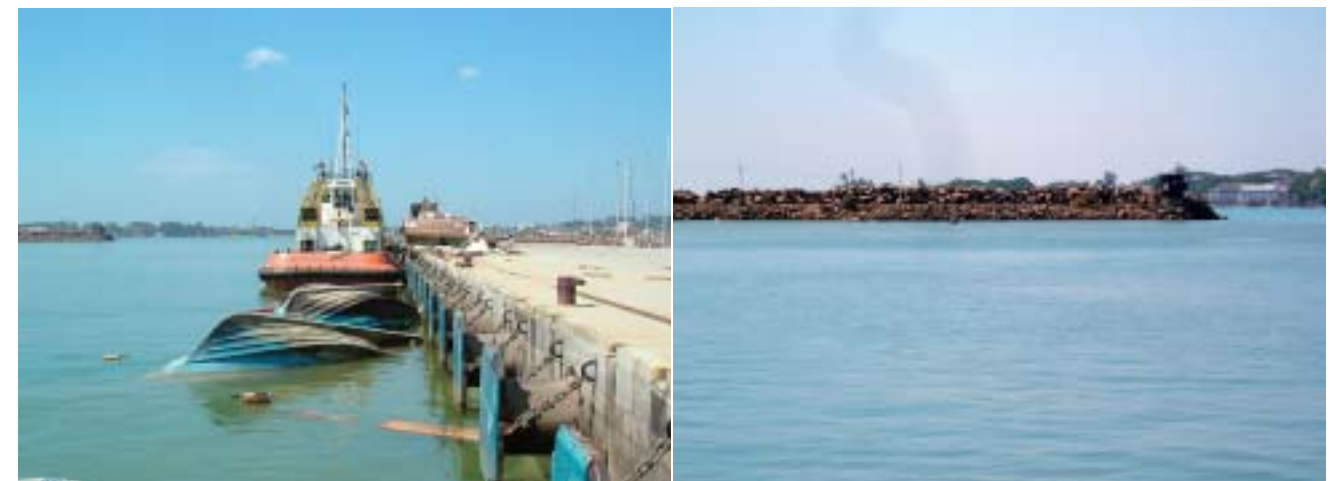
■写真4—転覆した漁船と港内タッグボート(津波襲来時は出船を案内して、港外に出ていて難を逃れた) ■写真6—津波による被害がなかった石積み防波堤(南側)
