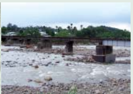
■写真3—第13号橋梁(竹崎駅付近)
