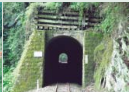
■写真2—里程51km付近のトンネル
