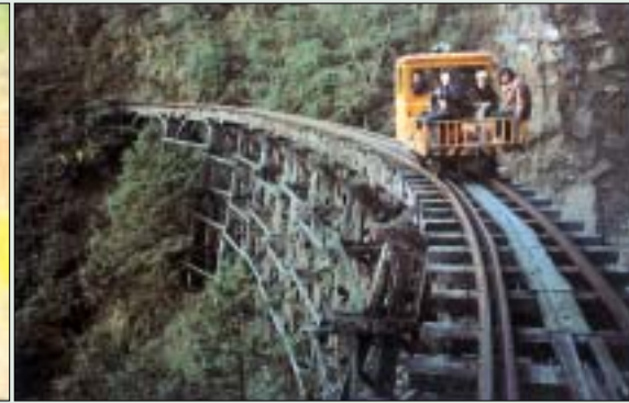
■写真4—木造の橋梁が建設当初を彷彿とさせる(林場線)
