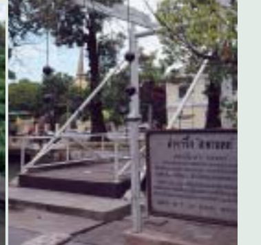
■写真11—架け替えられたルート運河の跳ね橋「ホック橋」
