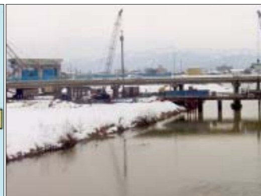
■写真2-異なる作業環境での請負工事
