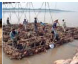
■写真3ーメコン河での粗朶沈床工の沈設
