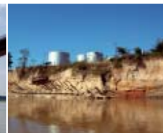
■写真2ー河岸侵食対策前の石油備蓄タンク(2001年12月)
