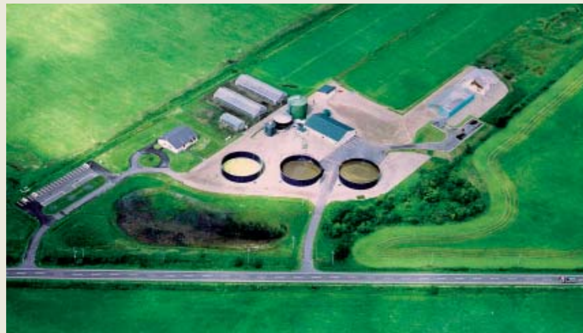
写真1—別海資源循環試験施設の全体写真
