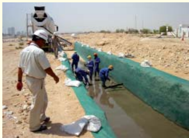
中近東における工事(写真:丸紅株式会社)
