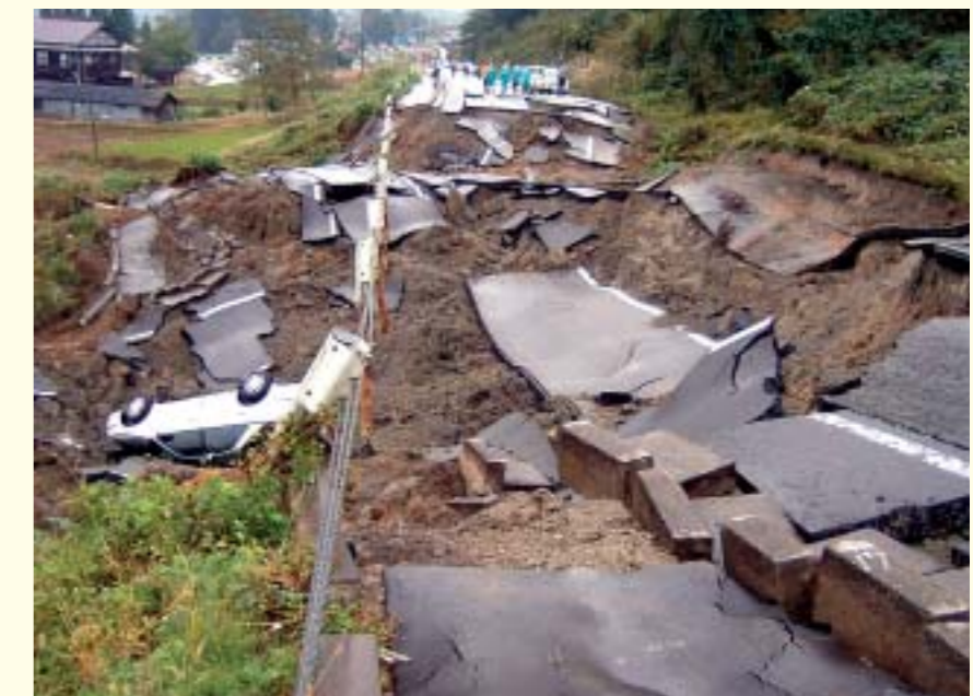
新潟県中越地震の被災した道路(写真:基礎地盤コンサルタンツ株式会社)
