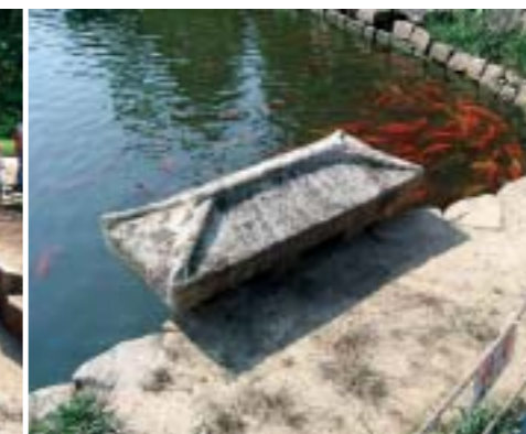
■写真6—水位を調整した出水口
