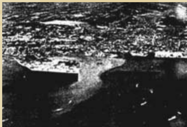
■写真2、3—四日市港 写真2は昭和46年頃、コンビナートから四日市港に工場排水が流れ出す様子。その後水質が改善され、埠頭に魚釣りを楽しむことも出来るようになった。(現在は保安上立入りが制限されている)
