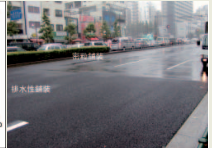
■写真11—雨天時の排水性舗装と密粒舗装の路面状態
