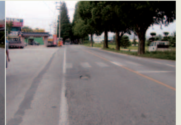
写真5—骨材剥離が見られる舗装面(駐車場出入口)
