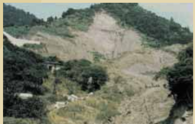
■写真2、3—濁り沢地区の地すべり 上は昭和49年、地すべり直後の写真。台風8号の影響による集中豪雨で、由比町地内各地に山地崩壊地すべり、土石流が発生。後に七夕豪雨と名づけられた。左は昭和58年、排土工、土留工など施工後の様子
