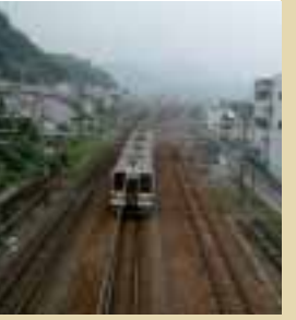
■写真8、9—由比駅付近 上は昭和36年頃の写真。土砂で線路が埋まり、総出で排土作業をしている。住民約400名に避難命令が出され、自衛隊300名以上が出動した。下は現在の線路の様子
