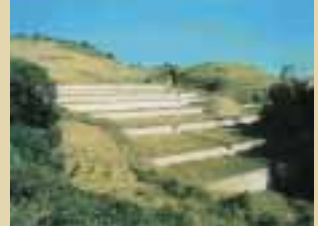
■写真2、3—濁り沢地区の地すべり 上は昭和49年、地すべり直後の写真。台風8号の影響による集中豪雨で、由比町地内各地に山地崩壊地すべり、土石流が発生。後に七夕豪雨と名づけられた。左は昭和58年、排土工、土留工など施工後の様子
