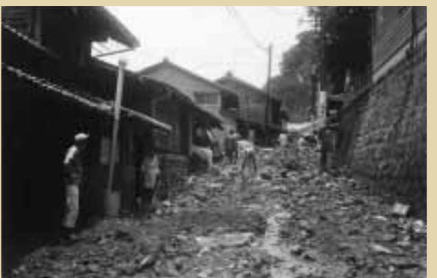
■写真4、5—由比町寺尾 上は昭和49年、七夕豪雨後の町の様子。土砂で道路が埋まっている。24時間雨量は508mmを観測し、静岡気象台創設以来の雨量を記録した。この災害により、政府は8月10日国土庁に「由比地区地すべり対策連絡会」を設置、第3次国営地すべり防止事業の始まりであった。右は現在の町の様子
