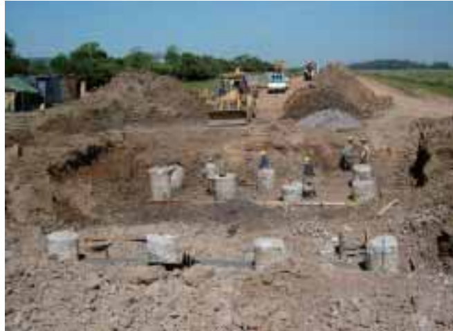
■写真3—なかなかかどらない建設現場の作業風景
