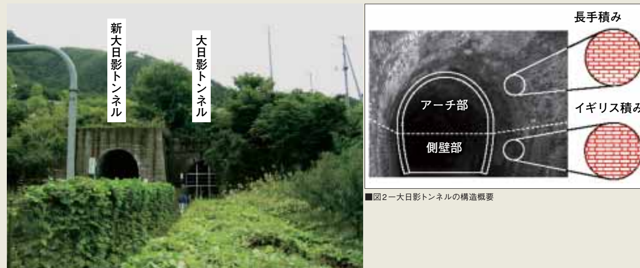
■写真1―大日影トンネル
