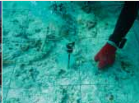
■写真7ーエアドリルで穿孔
