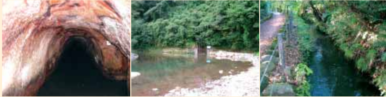
■写真7—壁面の風化が進む素掘りの辰巳用水暗渠部 ■写真8—現在の辰巳用水東岩取水口 ■写真9—藩士が用水監視で行き交った測道と辰巳用水
