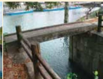
■写真3—柳川城堀水門。堀割の水を落とすときに使う「角落し」用の溝が掘られている
