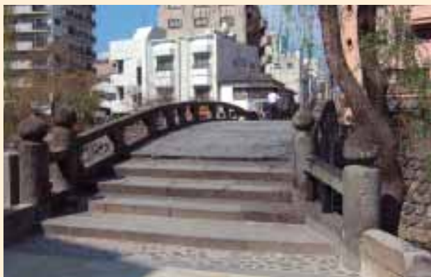
写真1—人道橋となっている眼鏡橋
