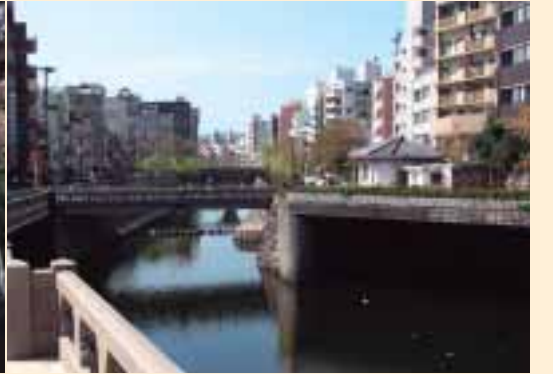
■写真7—眼鏡橋上流側に設けられた地下バイパス水路
