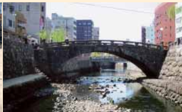
写真3—単アーチ技術の集大成「袋町橋」
