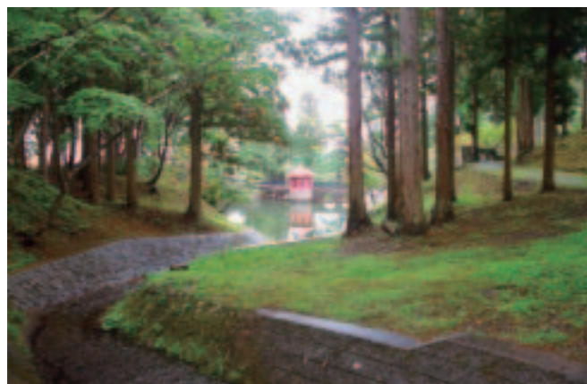
■写真3—堰堤背面から貯水池を望む
