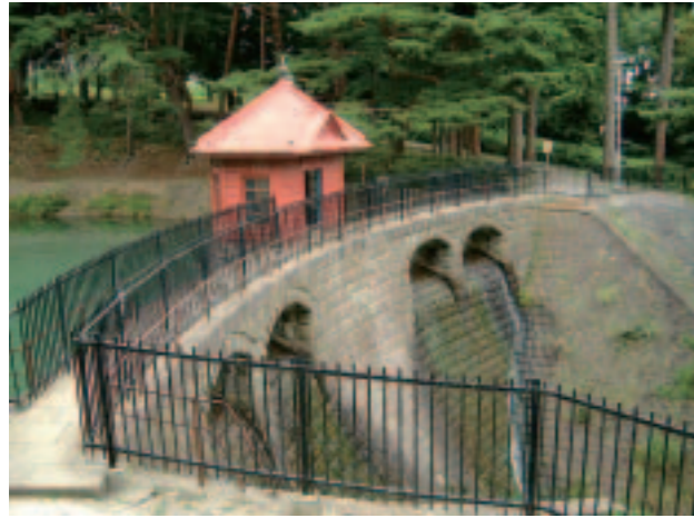
■写真2—側面より見た堰堤。大きなアーチ基部が判る
