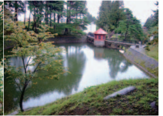
■写真6—貯水池全景。堰堤の奥に建設中の橋梁が見える
