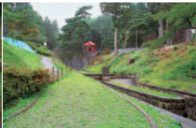
■写真4—第2取水口から堰堤を望む
