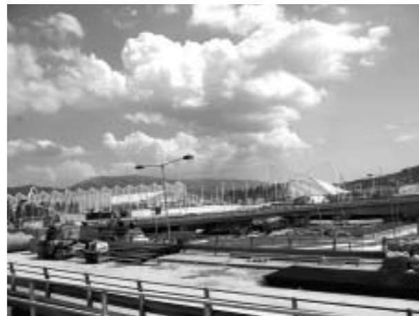
■写真2ー工事中のオリンピック・スタジアム全景
