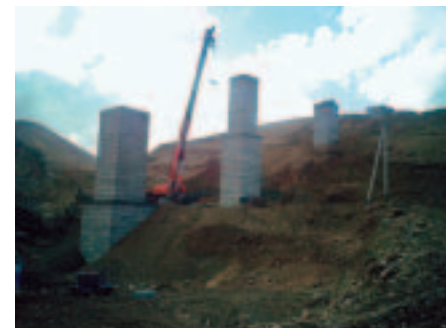
■写真8—橋梁建設現場 (B工区)
