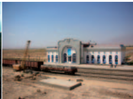
■写真9—駅舎建設現場
