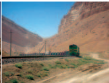
■写真10—工所用貨物列車 (C工区)
