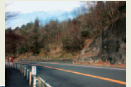
■写真8—設置完了後始点側道路からの景観
