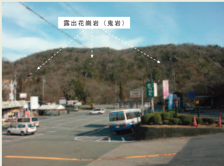
■写真1—斜面全景
