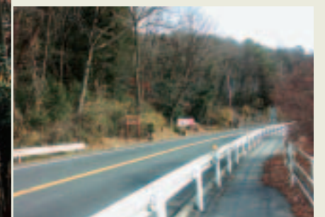
■写真9—設置完了後終点側道路からの景観
