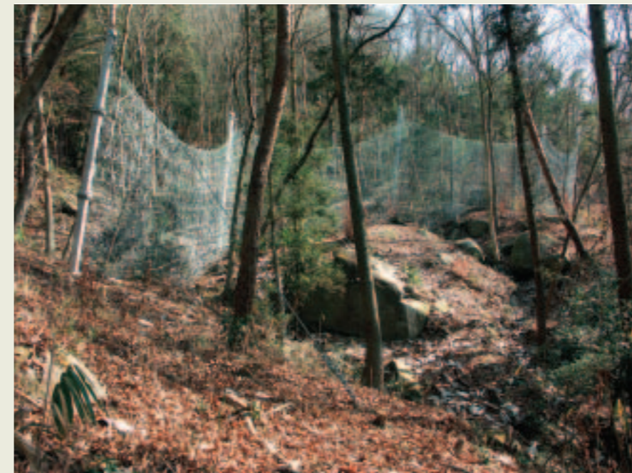
■写真7—高エネルギー吸収柵設置完了後状況
