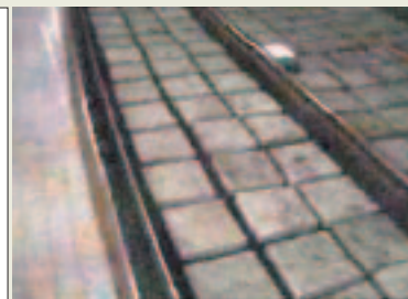
■写真4—保水ブロックの設置状況(中央駅)
