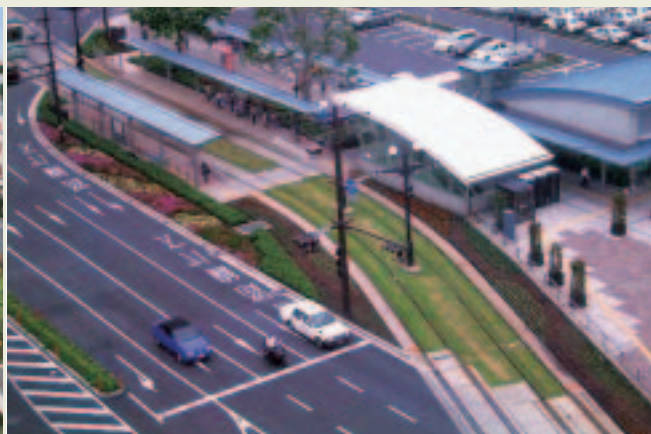
■写真2—軌道敷緑化部(完成区間)
