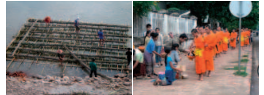
■写真4—ラオス人による粗朶沈床の水上組み立て (2005年)
