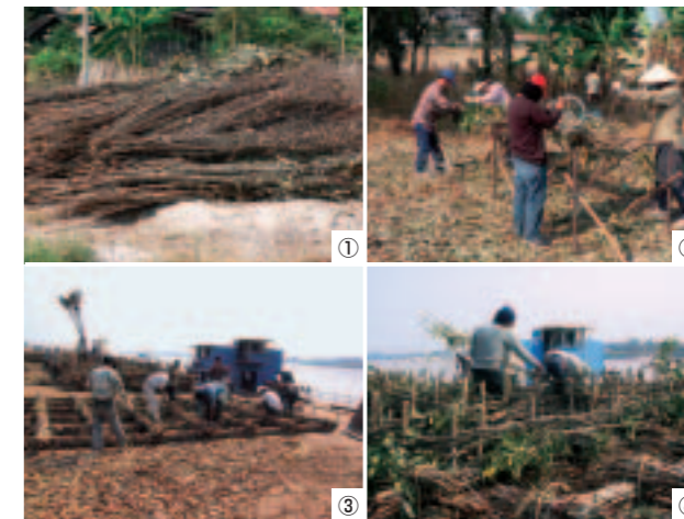
■写真2—伐り出した粗朶から粗朶沈床の製作の過程 ①:粗朶束 ②:連柴製作 ③:格子製作 ④:柵掻き
