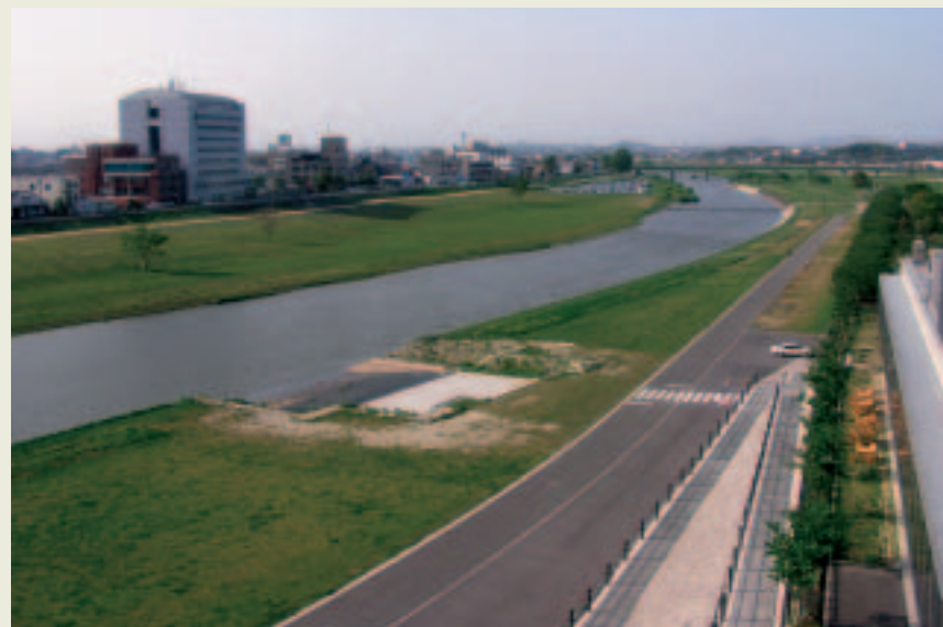
■写真3—整備が終了した遠賀川水辺館前
