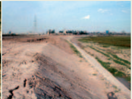
■写真12ー調整池掘削工事中に発生したすべり
