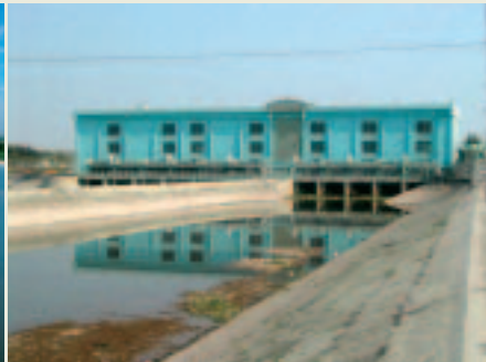
■写真3ーポンプ場前景
