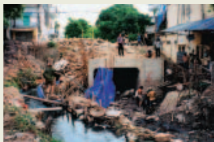
■写真8ーカルバート建設工事の様子
