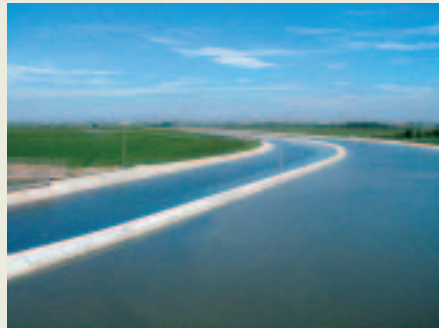
■写真2ーポンプ場向う開水路
