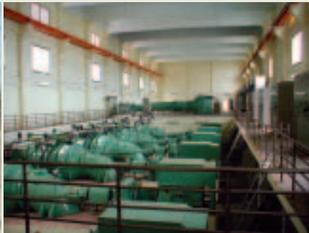
■写真4ーポンプ室
