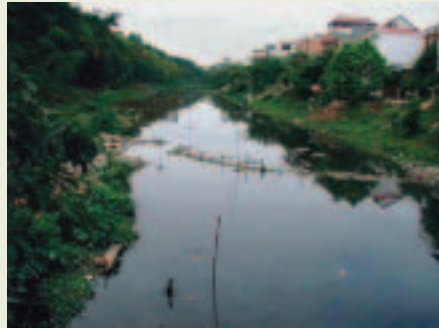
■写真5、6ートリック川改修工事前後の様子
