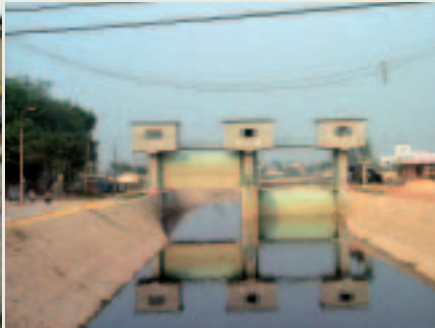
■写真7ータンリエット水門
