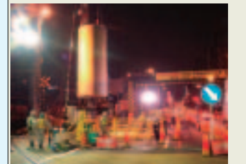
■写真2—柱の建込み
