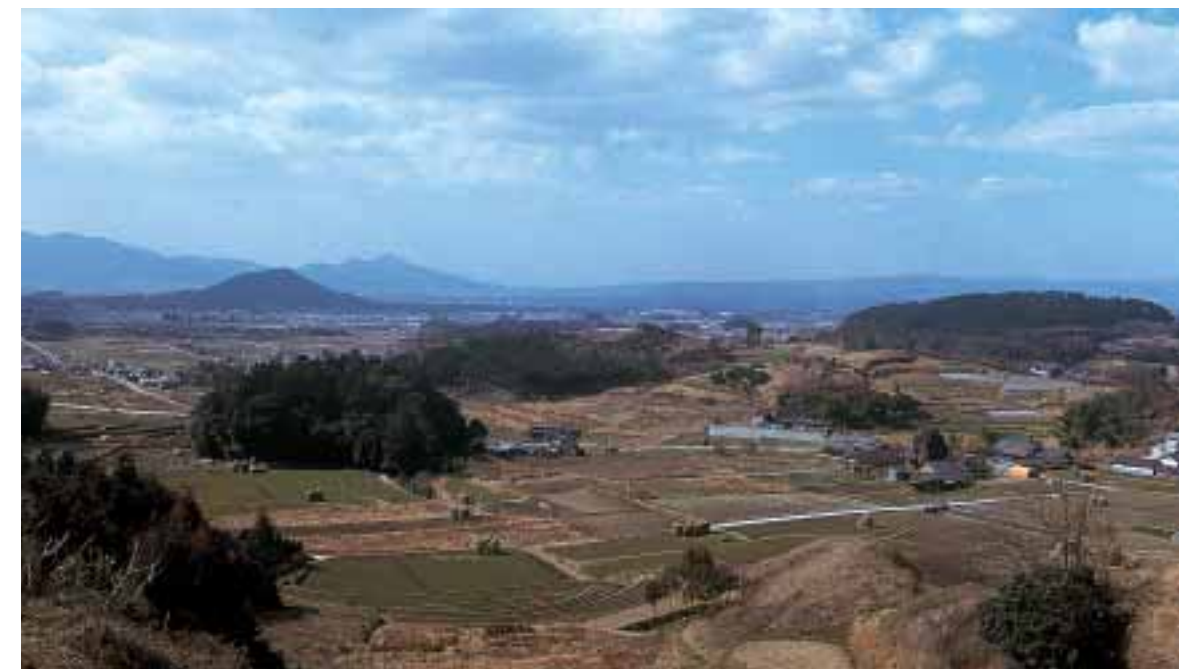
■写真4—山田寺跡。飛鳥盆地の東を限る多武峰山麓の傾斜地を、大規模に切土・盛土して伽藍地を平坦に造成している
