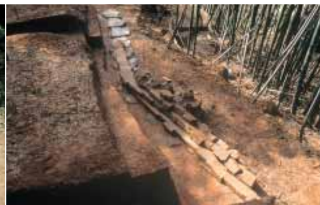
■写真2—酒船石遺跡の凝灰岩質砂岩切石による石垣。谷側に崩れている
