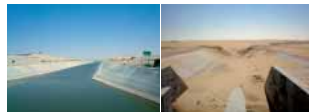
■写真6—北シナイへ送水するシェイクギャベルエルサバー水路 ■写真7—第6揚水機場の先で中断している水路
