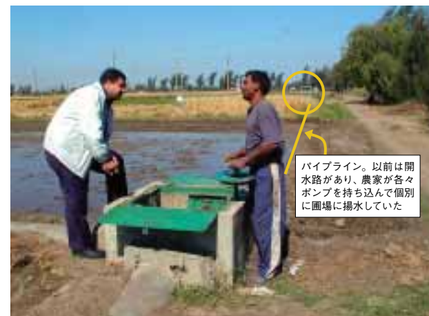
■写真8—デルタに日本の協力で新しく設置された末端パイプライン水路
