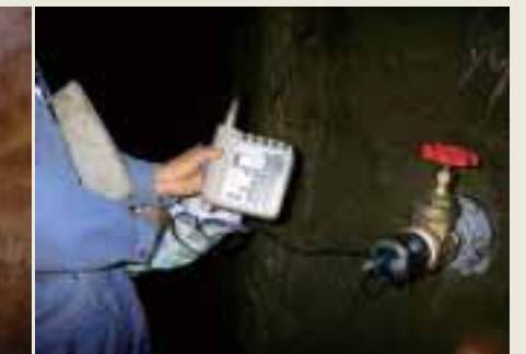
■写真4—地下水圧測定
