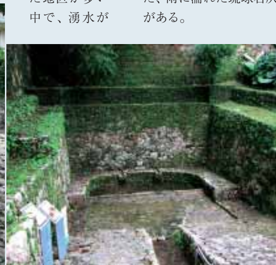
■写真4—共同井戸である金城大樋川
