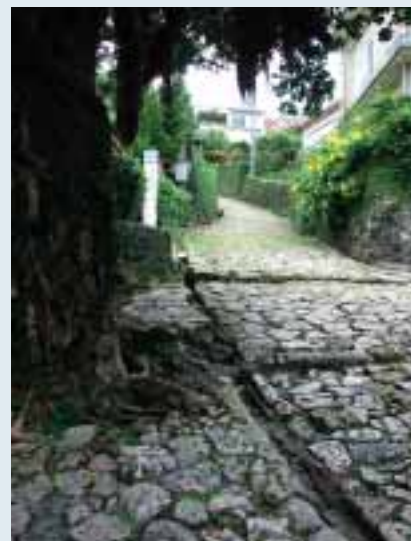
■写真3—排水溝と階段
