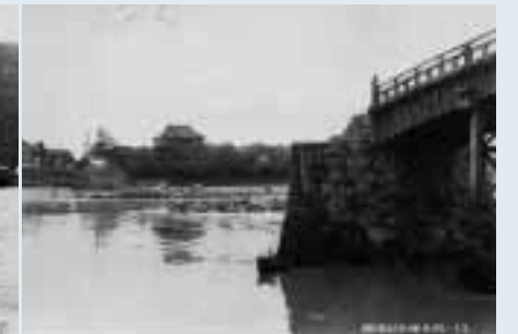
写真4—中央径間が流失した錦帯橋
