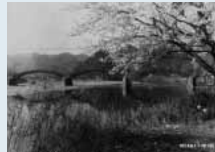
写真2—昭和17年頃の錦帯橋
