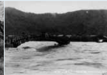
写真3—ギジア台風により水没した錦帯橋
