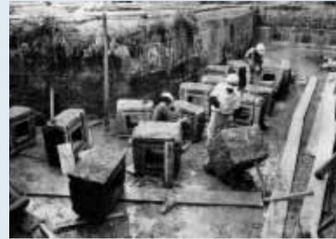
■写真8—1983~1984年の補修工事時の通水管解体作業
