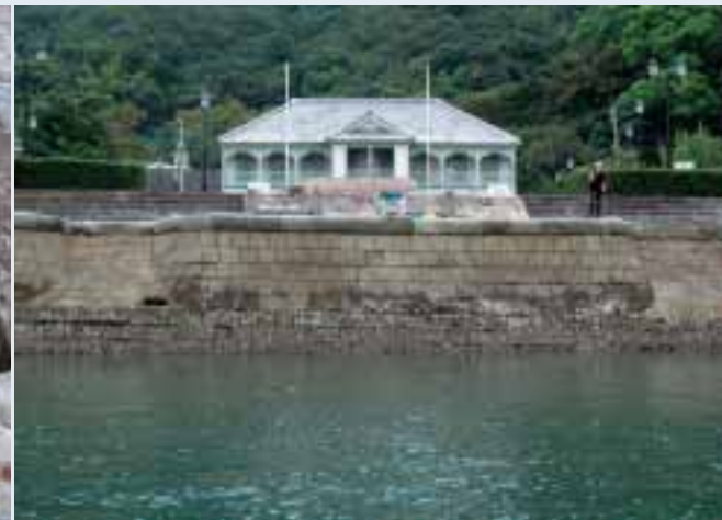
■写真2—浮棧橋設置箇所。背後にはハーンが宿泊した浦島屋(復元)
