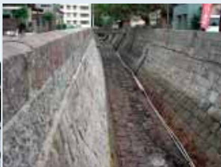
■写真5—底にも石が敷き詰められている西排水路
