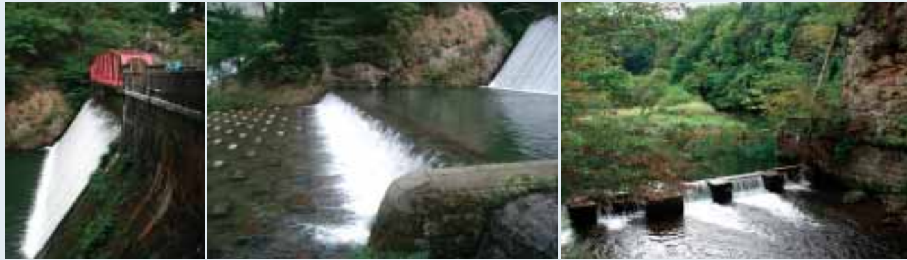
■写真5—本堰堤と管理用の橋 ■写真6—本堰堤の下にある副堰堤 ■写真7—かつて木橋が架けられてた放水路の堰と護岸
