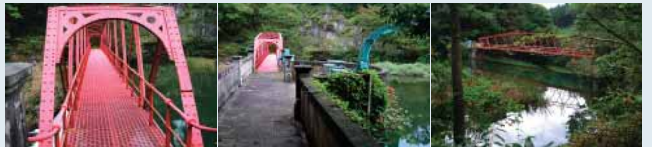
■写真8—管理用の橋 ■写真9—バルブ塔 ■写真10—上流側の貯水池と管理用の橋
