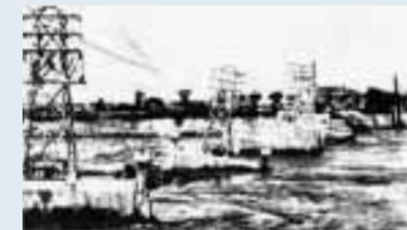
■写真4—陥没した自在堰。堰が斜めに傾いている
