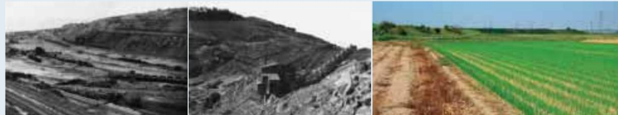
■写真1—1909年に開始された工事での河口付近の分水路掘削 ■写真2—工事中に発生した地すべり。大型機械が土砂に埋もれている ■写真3—遠くに見える「客土の丘」
