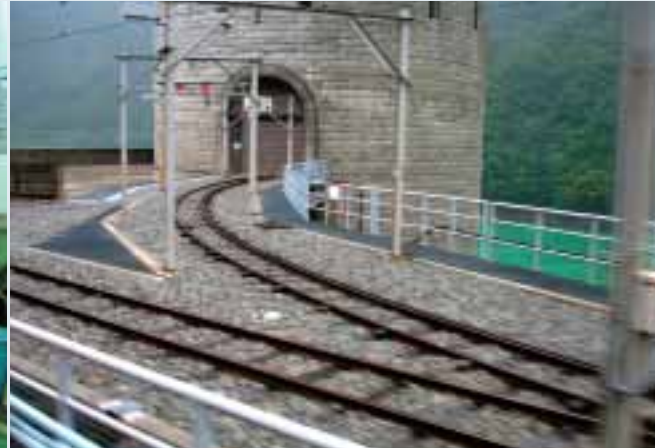
■写真12—発電所への引き込み線
