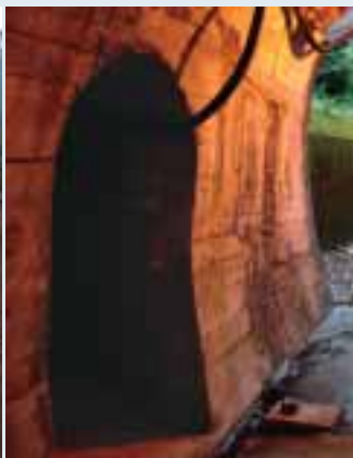
■写真14—冬期歩道トンネル
