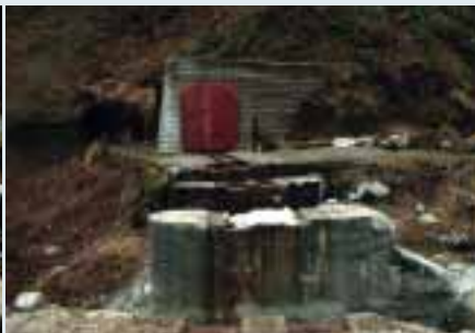
■写真10—橋梁が撤去された後
