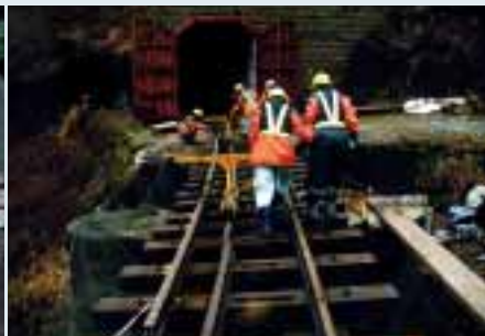
■写真9—冬期運休のための橋梁撤去作業
