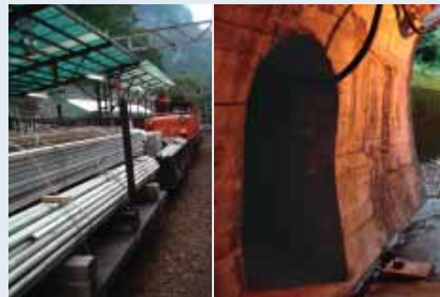
■写真13—工事専用列車
