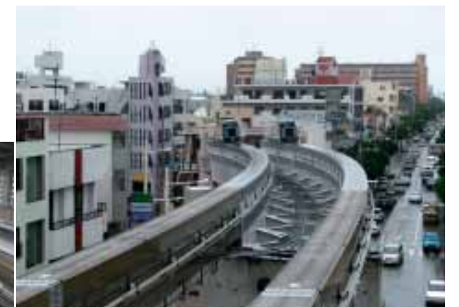
■写真7—終点の首里駅の軌道桁。今後、延伸される予定
