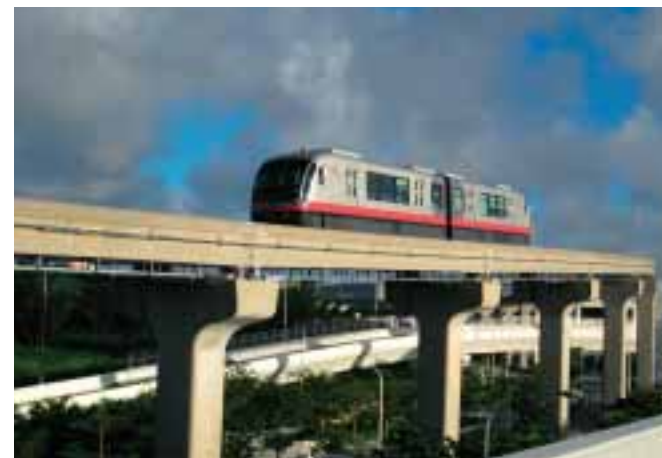
■写真1—那覇空港駅付近のゆいレール
