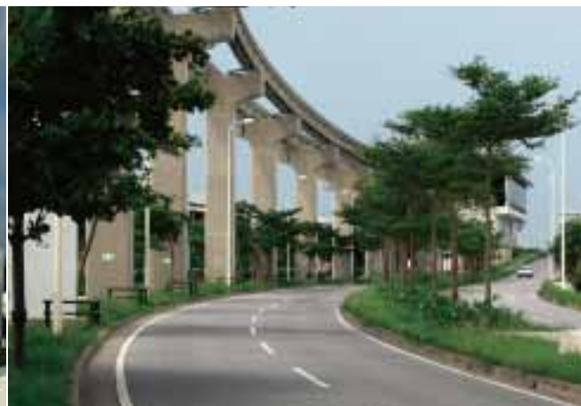
■写真2—那覇空港付近の軌道
