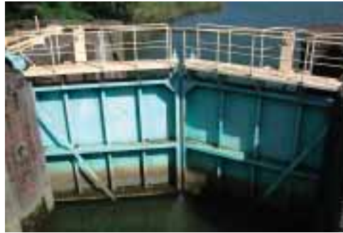
■写真4—石井閘門とマイターゲート
