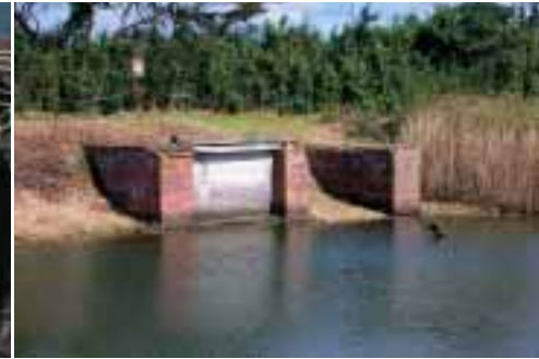
■写真5—野蒜港に残るレンガ造りの橋台
