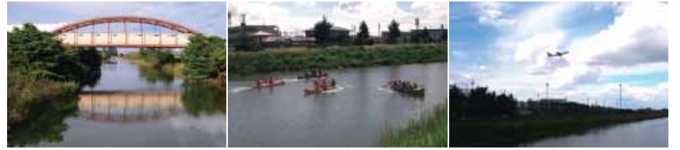
■写真7—新堰に掛かる南蒲生下水処理場の水管橋
