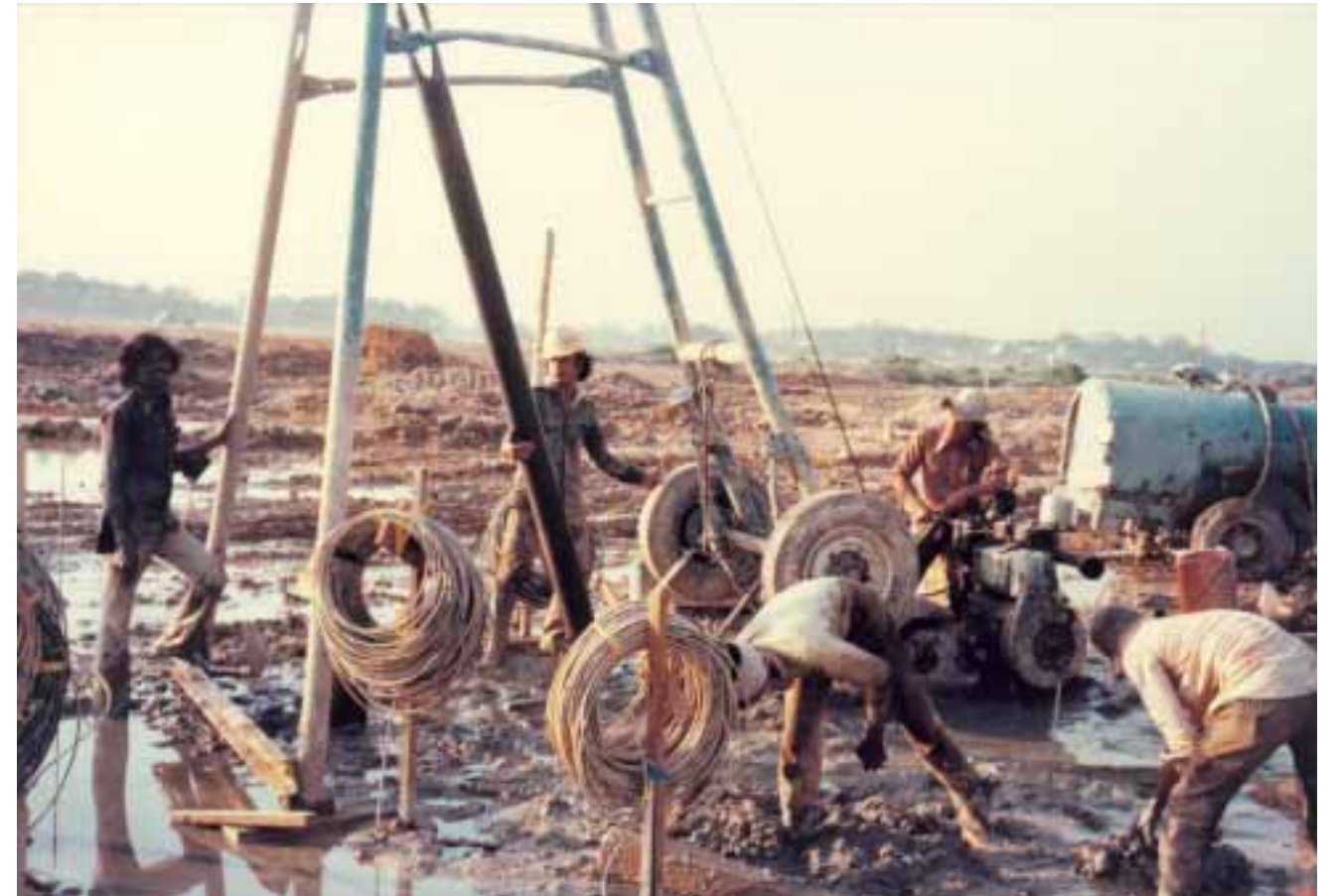
写真2 計器埋設孔用のボーリングマシン
