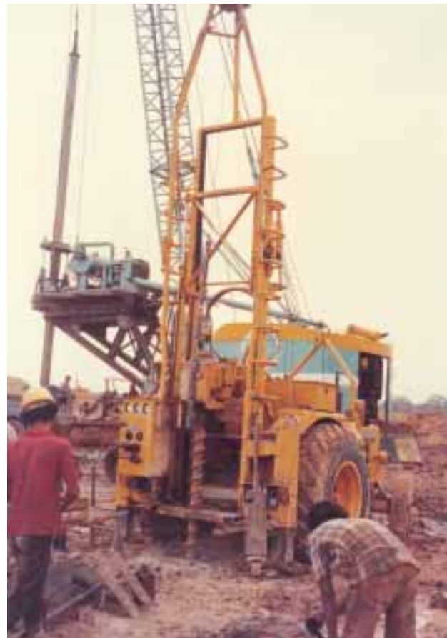
写真1 ボーリング調査
