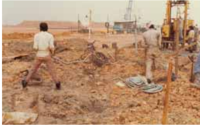
■写真5—計器埋設風景
