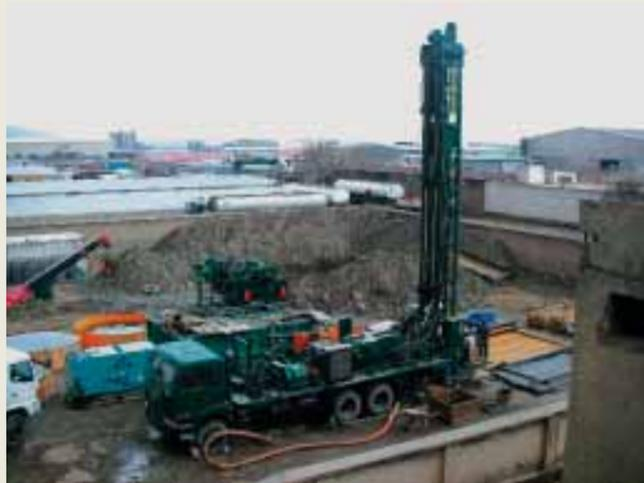
■写真2—600m級井戸の掘削機材(井戸掘削機・発電機・泥水濾過装置)(地上部分)
