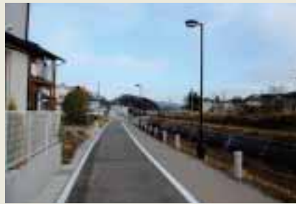
■写真9—下流部の転落防止措置の例(H20.1撮影)
