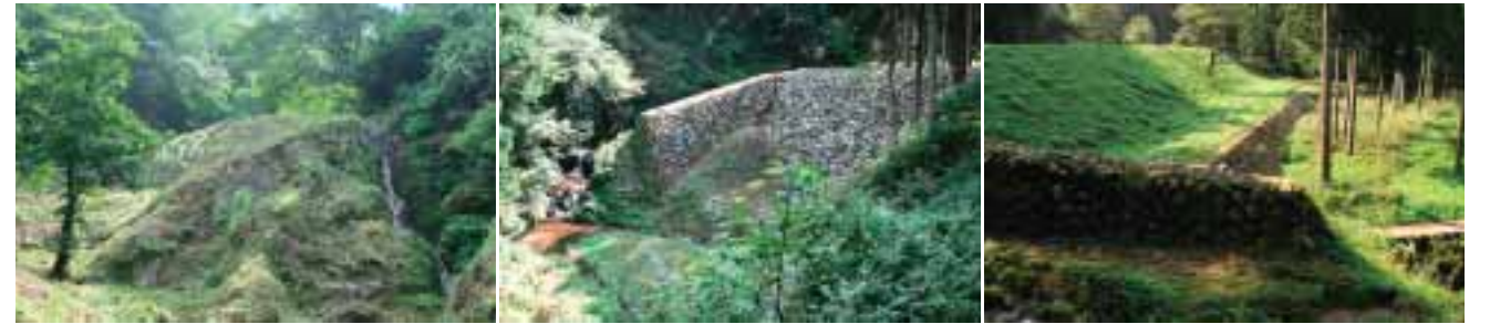
■写真3—水を右側の岩盤に誘導する3号大平中堰堤 ■写真4—杉林にひっそりたたずむ7号奥の東堰堤 ■写真5—アカタン最大の8号堰堤。手前が導流堤
