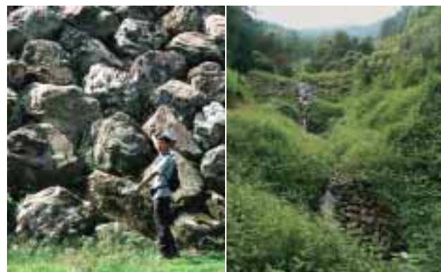
■写真1—松が端堰堤を構成する巨石 ■写真2—最上流部の1号大平ミズヤ上堰堤と2号大平ミズヤ下堰堤
