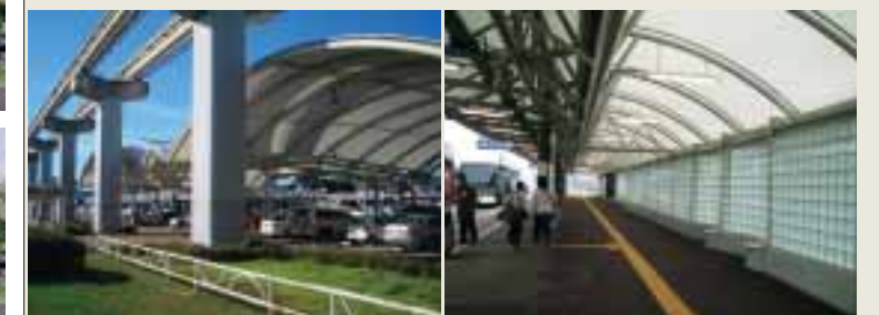
■写真7-身障者用駐車場のシェルター
