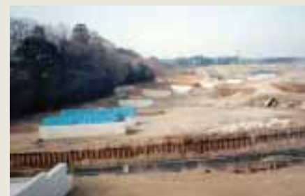
■写真5—堤台・岩名線の下部工事
