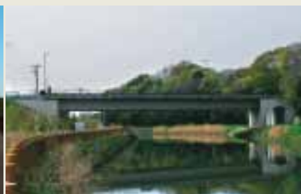
■写真7—座生川を跨ぐ山崎・吉春線の橋梁
