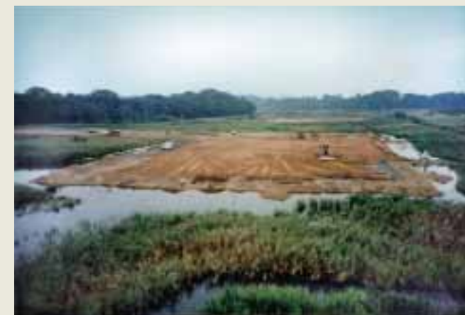
写真3—試験盛土工事
