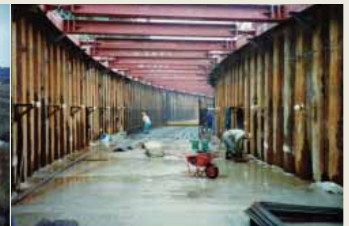
写真4—雨水堤台幹線工事
